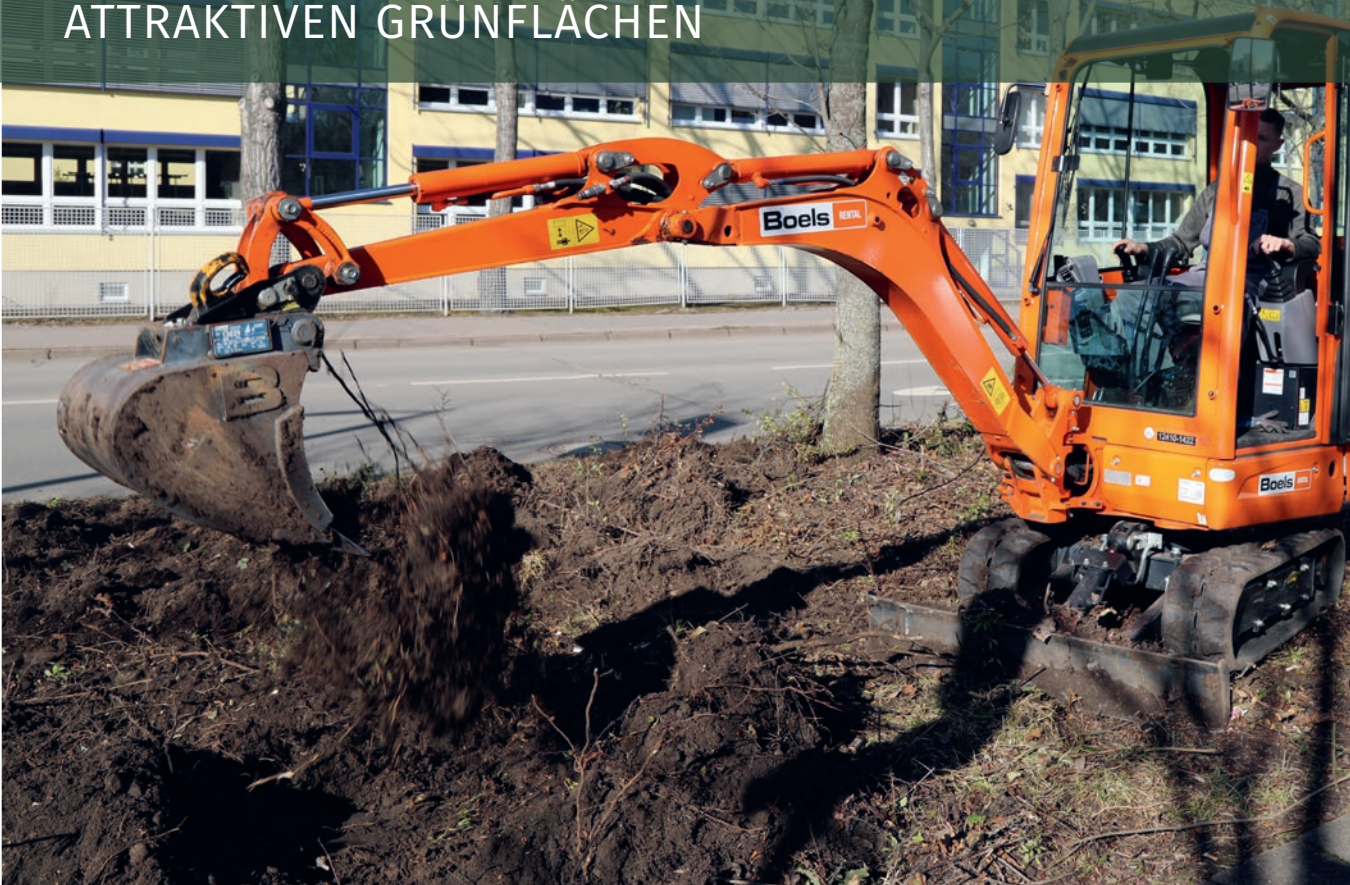
Wurzelwerk wurde vollständig entfernt.
